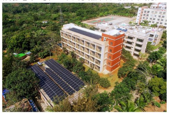
项目建成后平均每年可发电 26 万度,除学校正常使用外,剩余电量并入南方电网,每年可获得 10 万元左右的收益,同比火电每年可节约标煤 88 吨,并可减少多种大气污染物排放。
